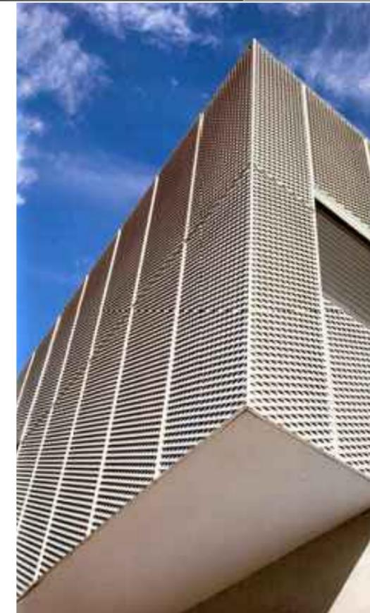
ПРИМЕРЫ НАРУЖНОЙ ОТДЕЛКИ ФАСАДНЫХ МЕТАЛЛИЧЕСКИХ ПАНЕЛЕЙ ИЗ ПРОСЕЧНО-ВЫТЯЖНОЙ СЕТКИ
